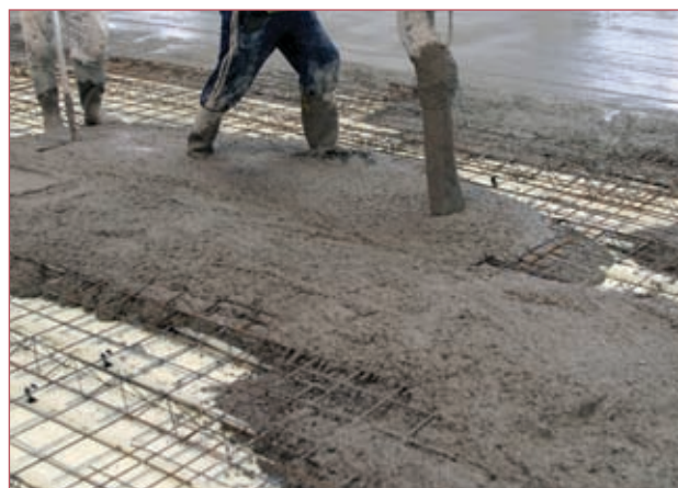
pokládání betonové výplně v průmyslové budově
