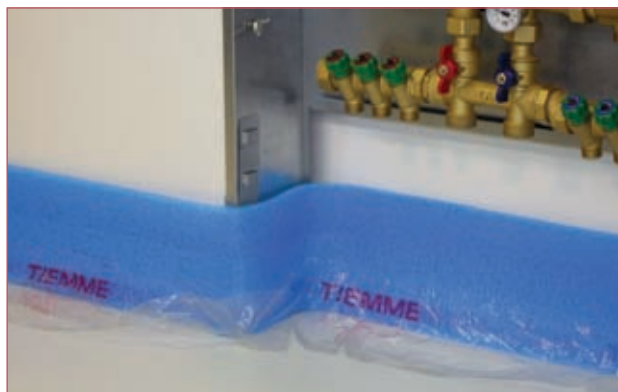
zakrytí ochranného krytu okrajovým lemem
