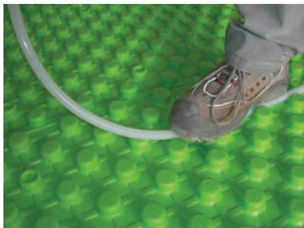
upevnění trubky k desce s výstupky
