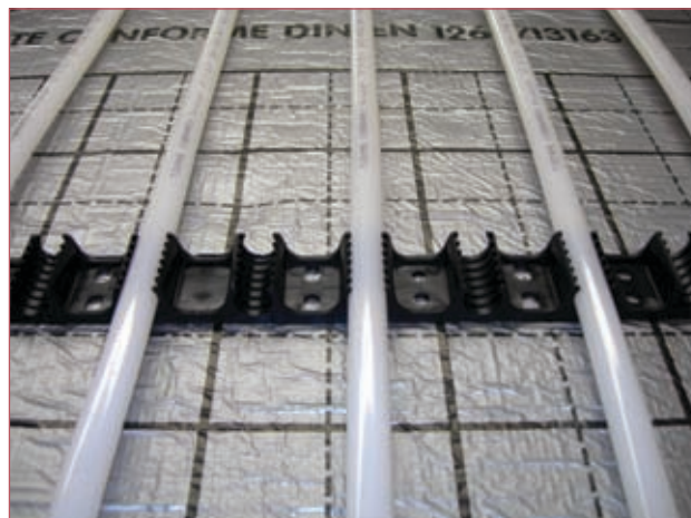
upevnění trubky pomocí uchytcovacích lišt
